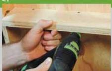
4. Отметьте положения направляющих под опоры для ног и прикрутите их с обеих сторон. Отпилите по размеру промежуточные рейки (поз. 16), которые крепятся между внутренней и внешней сторонами. Просверлите в рейках отверстия с резьбой (D = 4,5) и прикрутите их шурупами Spax (4 х 70).
