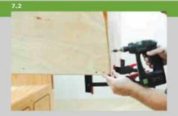
Отметьте выступы крыши с нижней стороны листа фанеры толщиной 6 мм (поз. 32). Зафиксируйте крышу на передней поперечине и выровняйте её. Отверстия с резьбой необходимо предварительно просверлить в крыше и обработать зенковкой. Сначала прикрутите (Spax 3,5 x 30) поверхность крыши к передней поперечине и затем всегда поочередно, слева и справа, к сторонам.
