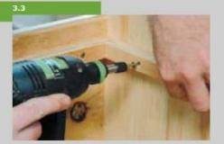
Отпилите ножовкой опорные рейки для посадочной поверхности и крышки (поз. 15). Просверлите отверстия под шурупы Spax (4 х 35) в рейках и прикрутите их в указанных положениях.
